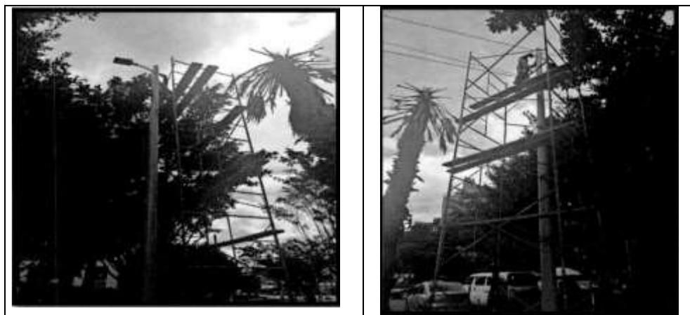
Imagen 7: Instalación de lámparas y brazos manualmente.
