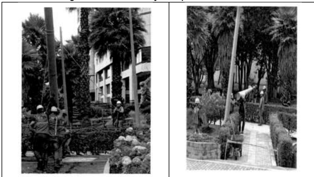
Imagen 6: Postes izados y transportados manualmente.
