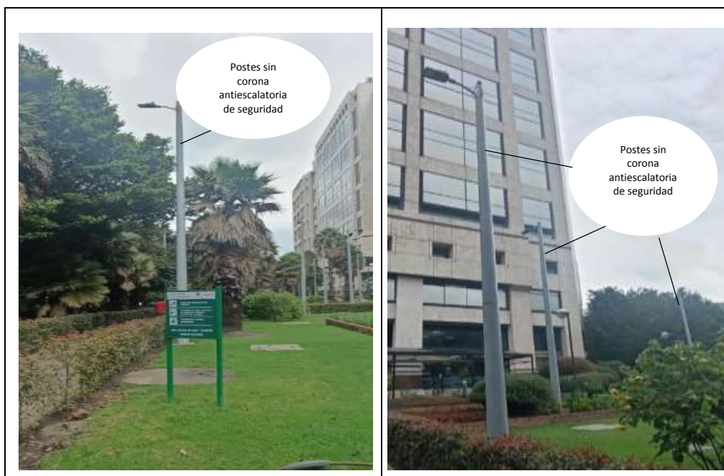
Imagen 5: Postes sin corona antiescalatoria de seguridad.
