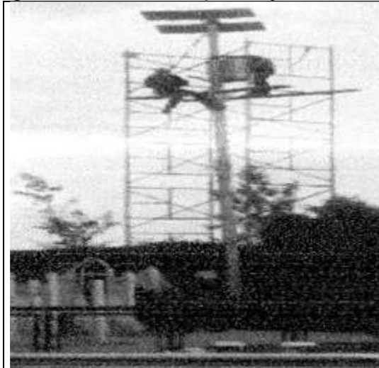
Imagen 8: Instalación de postes y luminarias predio 2.
